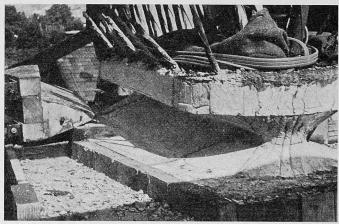
Bild 13. Betongelenk beim Hardturm-Viadukt beim Ausschalen
