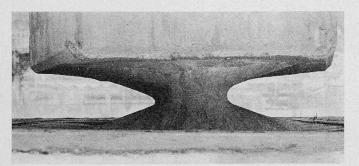
Bild 15. Fertiges Betongelenk beim Hardturm
