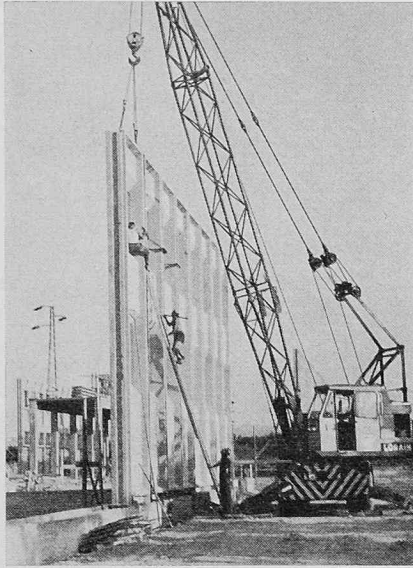
Bild 17. Montage von dreigeschossigen Aussenwänden zum Verwaltungsbau
