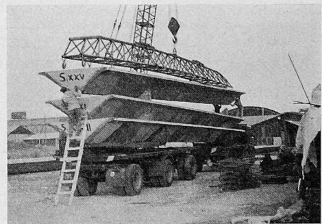
Bild 10. Verlad von «U»-Falterken auf Lastwagen
