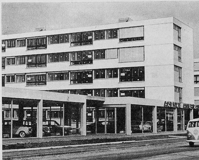
Bild 22. Ueberbauung in Muttenz bei Basel in der Grosstafelbauweise (System Koncz); die Innenwände wurden mit dem Wandfertiger hergestellt
