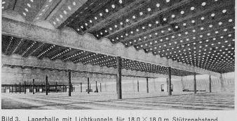
Bild 3. Lagerhalle mit Lichtkuppeln für  $18,0 \times 18,0$  m Stützenabstand
