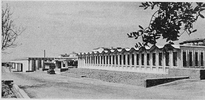
Bild 2. Hallenkonstruktion mit aneinandergereihten «U»-Faltwerken in Sesto Fiorentino / Italien. Ausführung CODELFA, Milano
