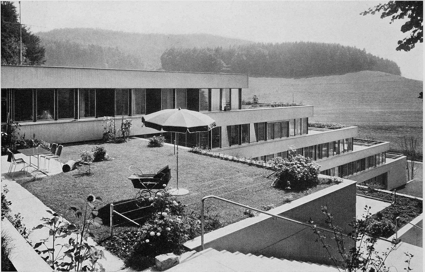
Der westliche Beobachtungstrakt mit den äusseren Terrassenstufen
