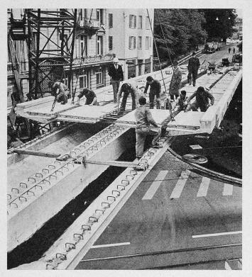
Bild 10. Auflegen der Fahrbahnplatten
