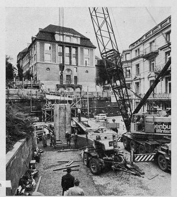
Bild 7. Versetzen der Stütze. Der erste Träger liegt bereit, Blick gegen die Töchterschule
