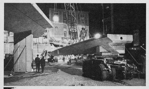
Bild 9. Anfügen der zweiten Trägerhälfte, Die Verbindungsstellen zwischen den Trägerhälften sind deutlich erkennhar
