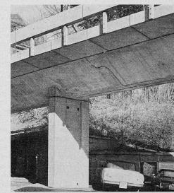
Bild 12 (rechts). Zwischenstütze mit Gerbergelenk
