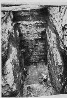
Bild 14. Felskluft unter den Fundamenten der Gipfelstation
