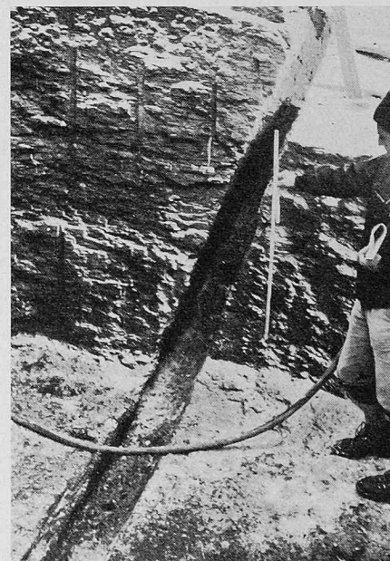
Bild 14. Felskluft unter den Fundamenten der Gipfelstation
