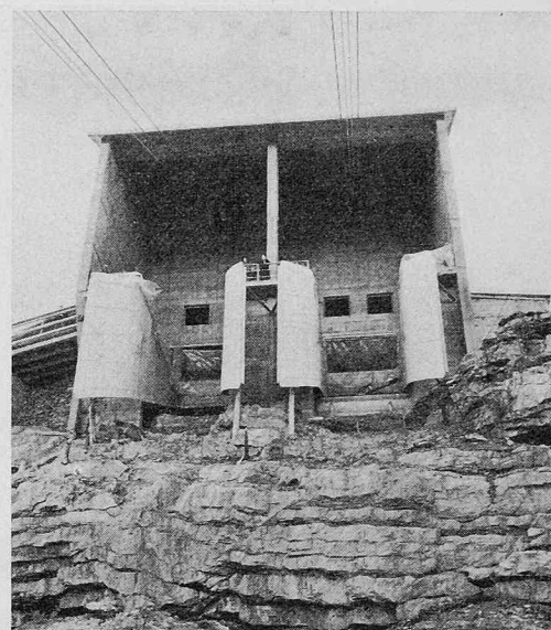
Bild 6. Stationsgebäude Birg. Einfahrtshalle der 3. Sektion
