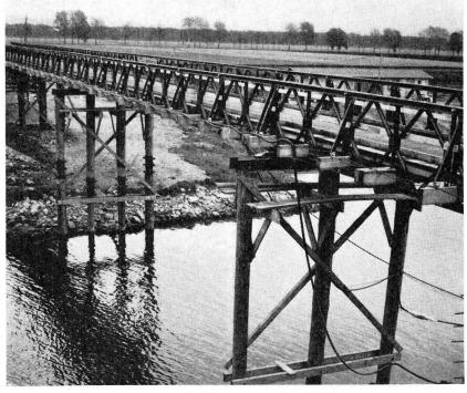
BAILEY Brücke «La Sauge» auf der Strasse Witzwil—Cudrefin zur Umleitung des Verkehrs während des Umbaues der bestehenden Brücke Länge der Brücke: 75 m, Breite: 3,5 m Zulässige Verkehrslast 12 Tonnen, Montagezeit: 2 Tage
