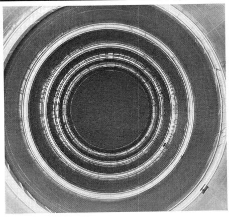
IRONFLEX-PVC-Innenauskleidung eines 100 000-I-Heizöltanks
