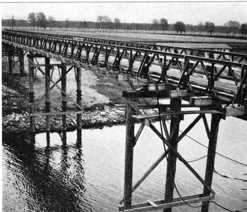
BAILEY Brücke «La Sauge» auf der Strasse Witzwil—Cudrefin zur Umleitung des Verkehrs während des Umbaus der bestehenden Brücke Länge der Brücke: 75 m, Breite: 3,5 m Zulässige Verkehrslast 12 Tonnen, Montagezeit: 2 Tage
