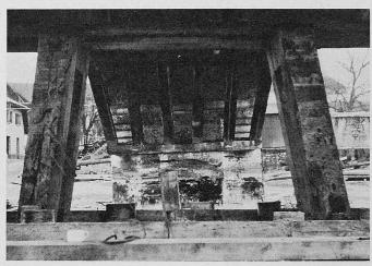
Bild 22. Durchblick durch das 1934 erstellte, eichene Joch 3 auf den talwärts geneigten Steinpfeiler. Am untern Bildrand bereits die Pfeilerschalung
