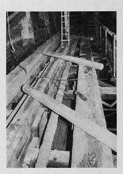
Bild 26. Oeffnung I. Balken 2 von rd. 2,6 t, mit einfachen Mitteln eingebaut. Balken 3 und 4, von oben her morsch auf der ganzen Länge (rechts im Bilde)
