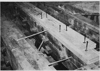
Bild 27. Oeffnung IV. Einbau der eichenen Schiftung auf drei doppelt verdübelten, 1934 eingebauten Längsbalken 1—3. Oben rechts Versatz der Hängewerkstrebe im Längsbalken 1
