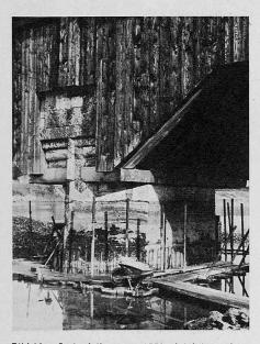
Bild 23. Steinpfeiler von 1552. Injektionsrohre, der Larssenkranz ist noch knapp über dem Wasserspiegel sichtbar
