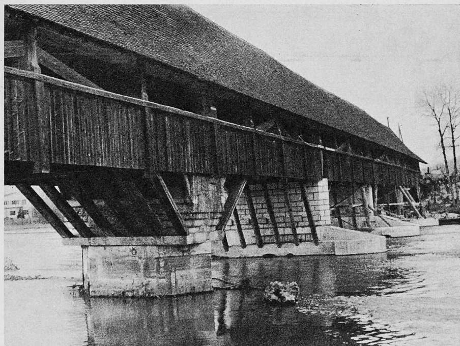
Bild 28. Öffnungen V—I unterwasserseits. Bei den Betonpfeilern sind noch die provisorischen Abstützungen vorhanden. Der zukünftige Stauspiegel wird bei UK der Konsolen liegen
