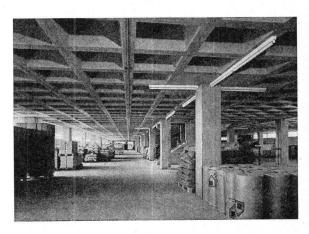
Vermietung von ausschalbaren Kunstharzschalungen für die Konstruktion von Kassettendecken mit gekreuzten Rippen. Ausgezeichnete Betonansicht der ausgeschalten Decke ohne nachherige Behandlung. Normierte Grössen. Spezialfabrikation auf Bestellung.
