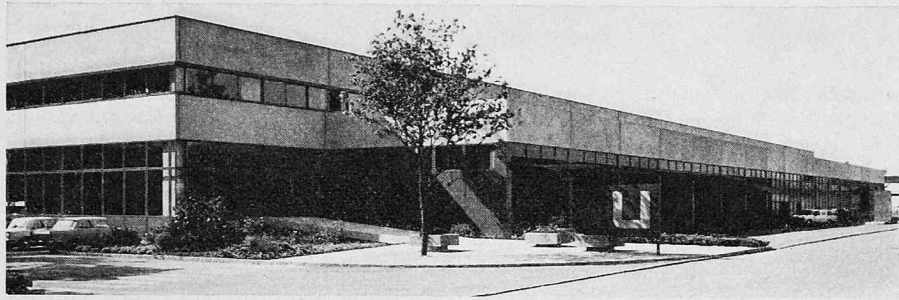
Verteilzentrale USEGO in Lyss, Gesamtansicht
