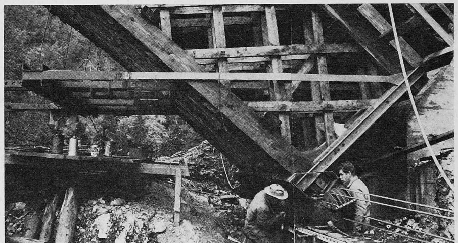
Teufelsschluchtbrücke, Freivorbau des Lehrgerüsts
