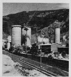
Bild 3. Bauzustand nach dem Erstellen der Silokörper
