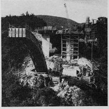
Freivorbau des Lehrgerüsts, Oestlicher Teil mit sieben Elementen fertig montiert
