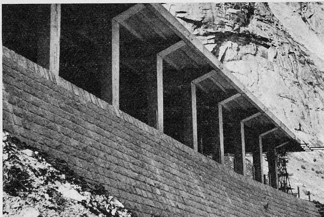
Uberschwere Lawinengalerie (MS), Blick vom alten Gotthardweg. Bauzustand Oktober 1966
