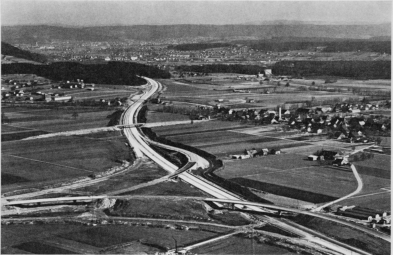
Verzweigung der N 1 und N 2 in Härkingen SO. Photo Comet aus Südwesten
