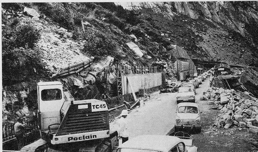
Ueberschwere Lawinengalerie (MS). Endlose Autokolonnen erschweren die Bauarbeiten. Bauzustand Juli 1966
