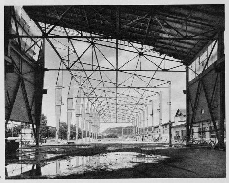
Bild 1. Montage der Stahlkonstruktion
