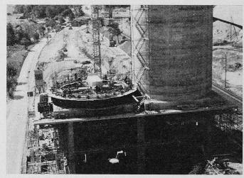
Bild 2. Um-Installation der Gleitschalung
