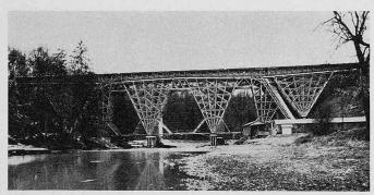
Bild 1. Ansicht des Lehrgerüstes von der Oberwasserseite bei Minimal-Wasserstand der Aare
