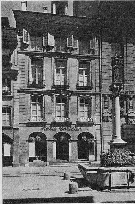
Bild 8. Marktgasse 52. Vor dem Umbau
