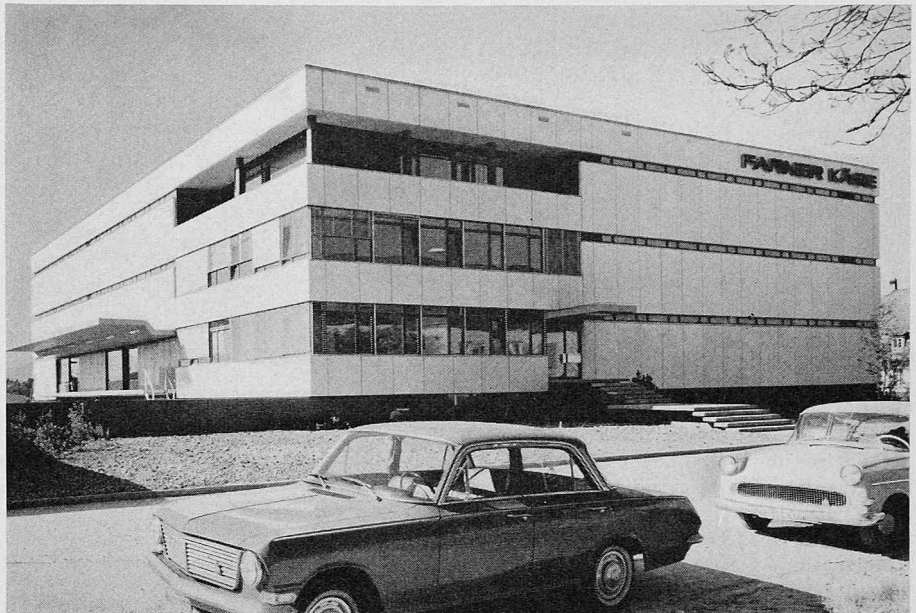
Gesamtansicht mit Warenanlieferung und Büroeingang
