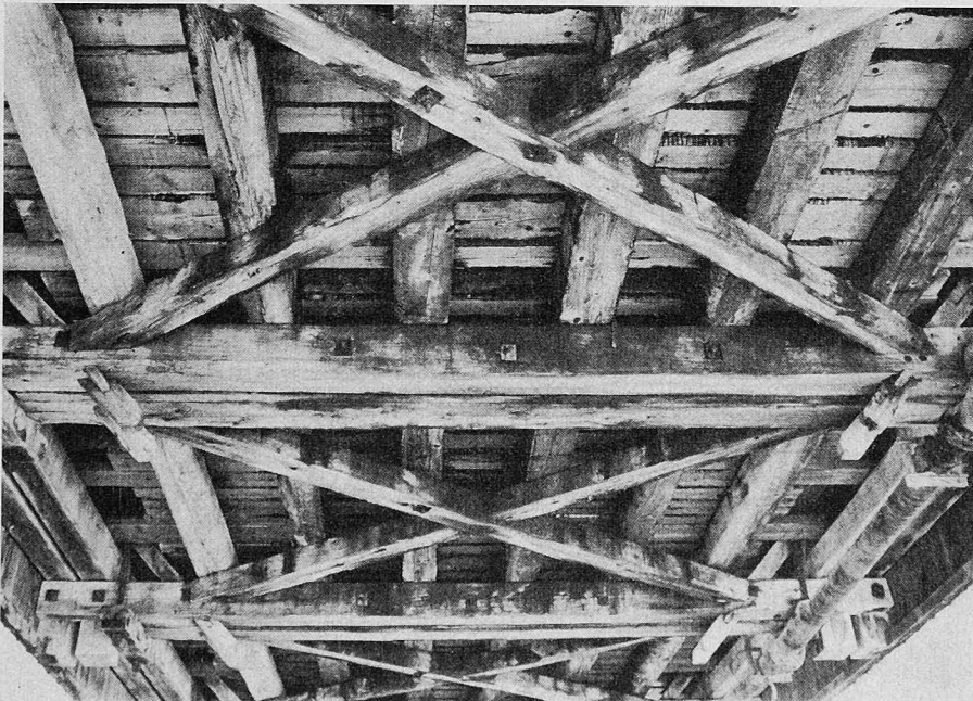
Bild 14. Schüpbach: Untersicht, Brückenbreite 7,0 m, sekundäre Längsträger 30 \times 30 cm, mit Stützweiten von 3,50 m. Vgl. Entwicklung innert 300 Jahren mit Bild 5
