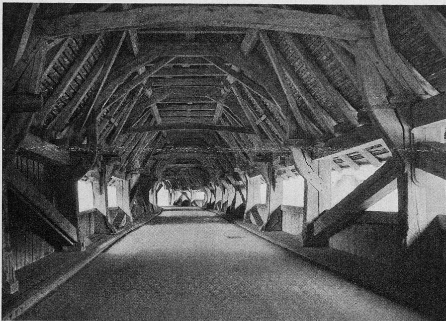
Bild 12. Neubrücke, Bern (1532): Erster Dachbinder mit Zugholz und Druckbügen in der mittleren Rahmenecke, folgender Binder mit Zugbügen und klaffendem Versatz
