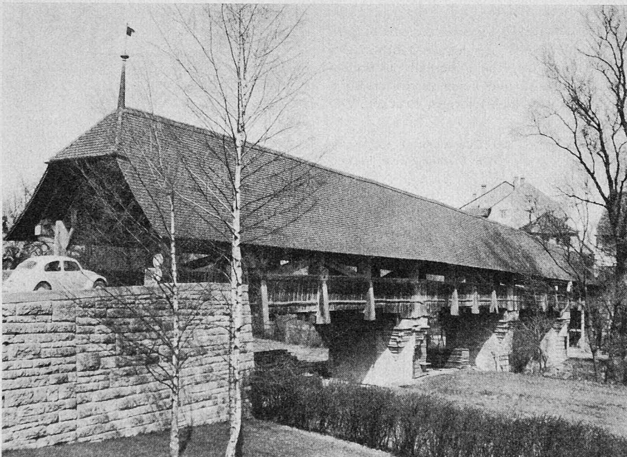
Bild 4. Aarberg: Erbaut gemäss Inschrift 1568, renoviert 1786. Bis auf Verbindungen fast vollständig im ursprünglichen Zustand erhalten
