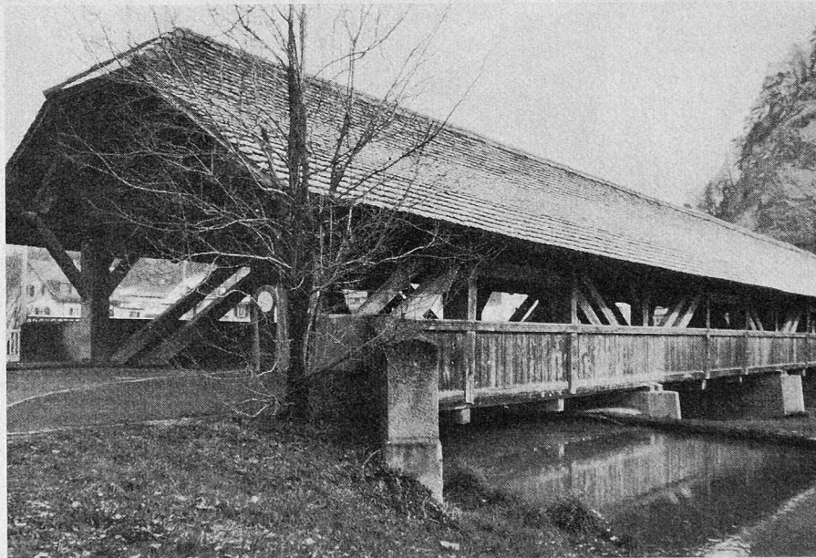
Bild 9. Wynigen (1764): Zwei parallel laufende, voneinander unabhängige Hängewerke
