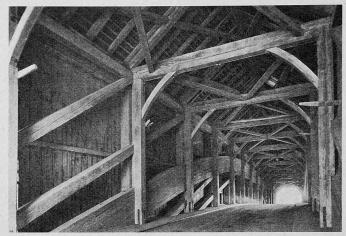
Bild 16. Hasle: Aus sieben Balkenlagen verzahnter Bogen. Man beachte oberen Windverband und Dachbinder mit vertikalen Pfosten
