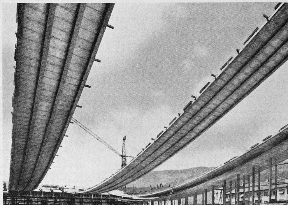
Bild 6. Bauetappen des Hängedaches
