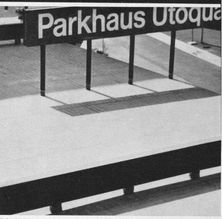
IRONFLEX-Flachdachbelag aus Trevira-verstärktem PVC ohne zusätzliche Schutzschicht, hochfrequenz-verschweisst.
