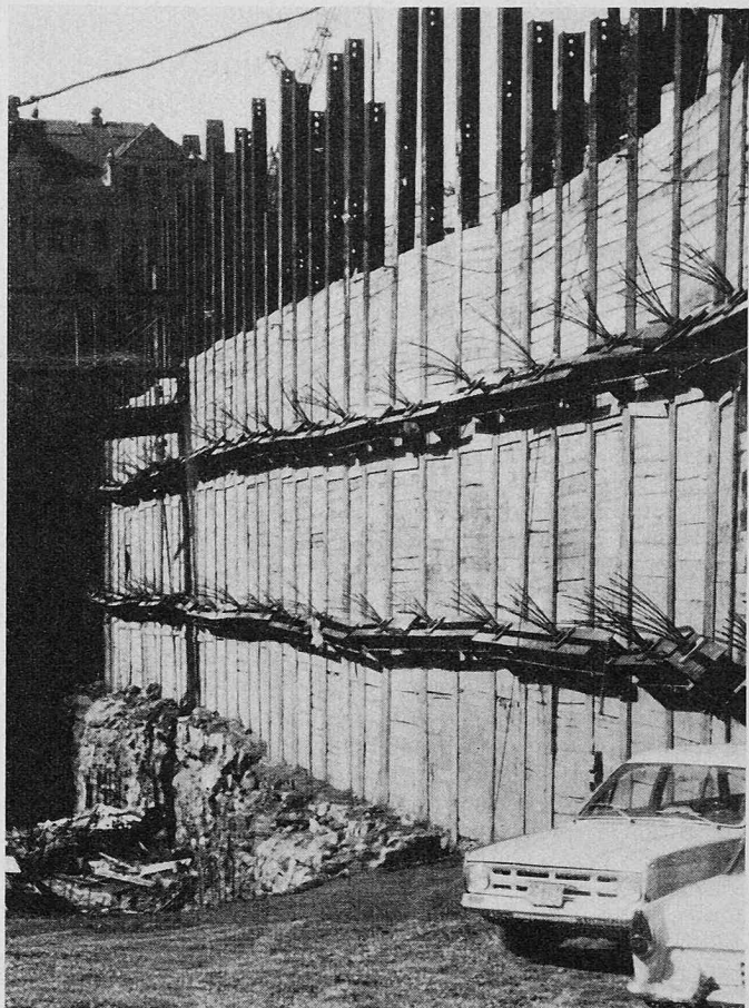
Bild 6. Offene Baugrube mit rückverankerter Wand
