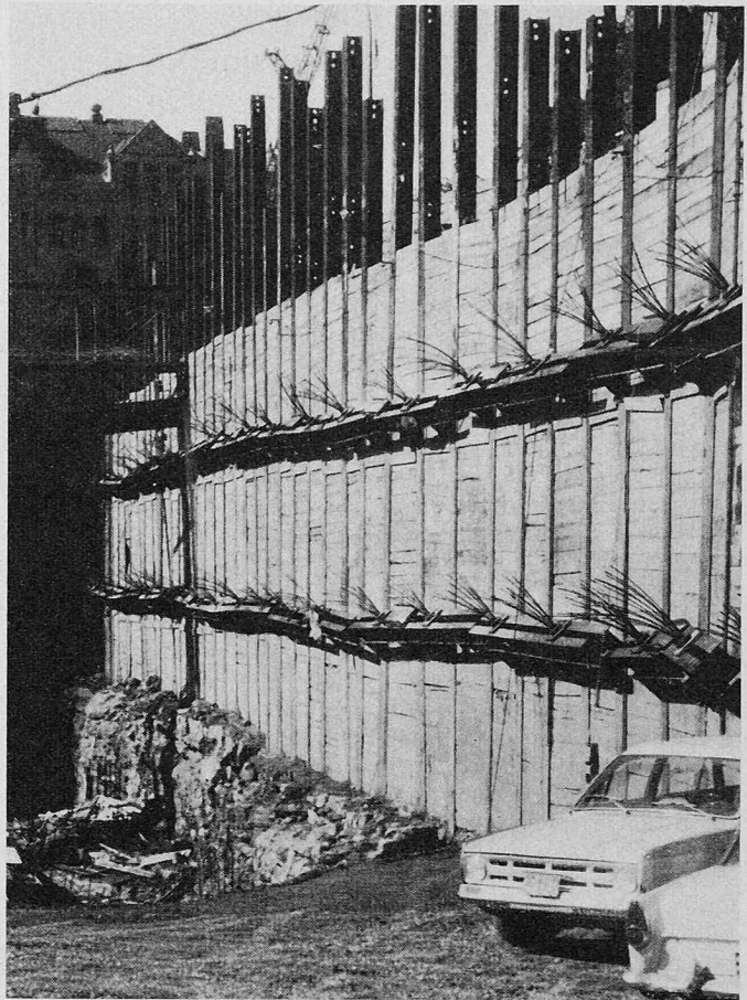
Bild 6. Offene Baugrube mit rückverankerter Wand
