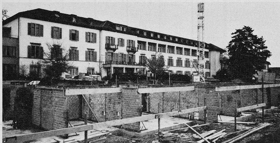
Preton-Elemente im Erweiterungsbau des Kreisspitals Männedorf
