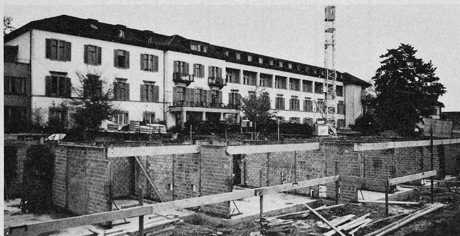
Preton-Elemente im Erweiterungsbau des Kreisspitals Männedorf
