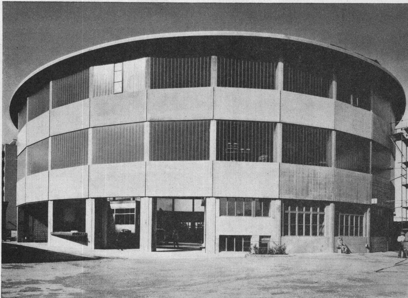
Rundhalle System Züblin, Muffenz BL
