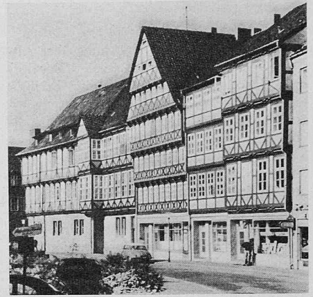
Hannover. Wiederaufgebaute Fachwerkhäuser
