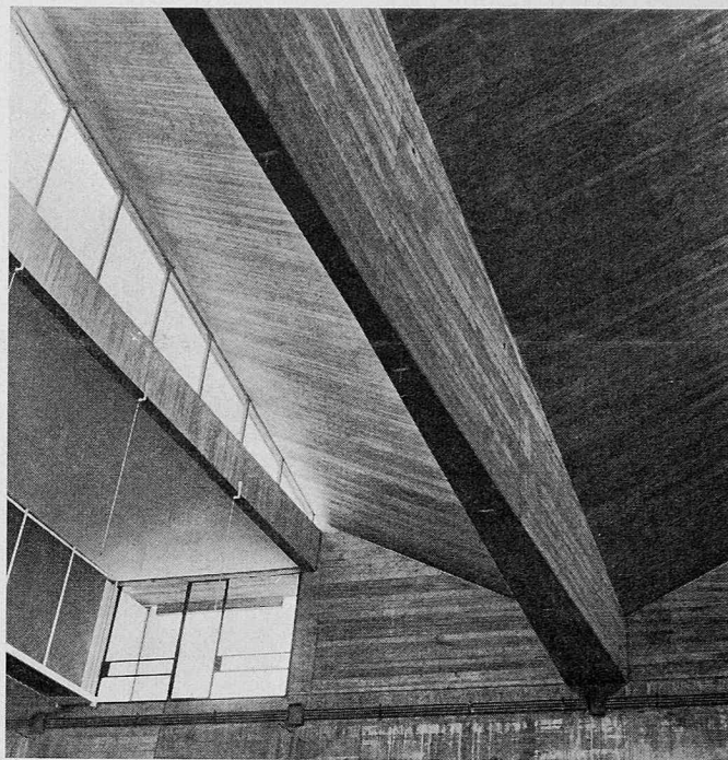
Bild 5. Untersicht der Hallenkonstruktion mit Hängestangen zur Befestigung der untergehängten Hohlkörperdecke
