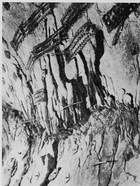
Bild 33. Bruchbildung und Verankerung bei der Druckentlastung im Montblanc-Tunnel. Man beachte das scharfe Auskeilen der abgelösten Gesteinsplatten infolge Scherbruch (vgl. Bild 32) [23, 24]
