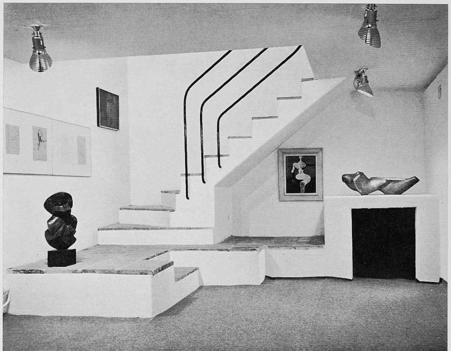
Untergeschoss Galerie Läubli mit neuem Trepenaufgang ins Erdgeschoss. Alte Tonplatten aus dem Keller wurden wieder verwendet
