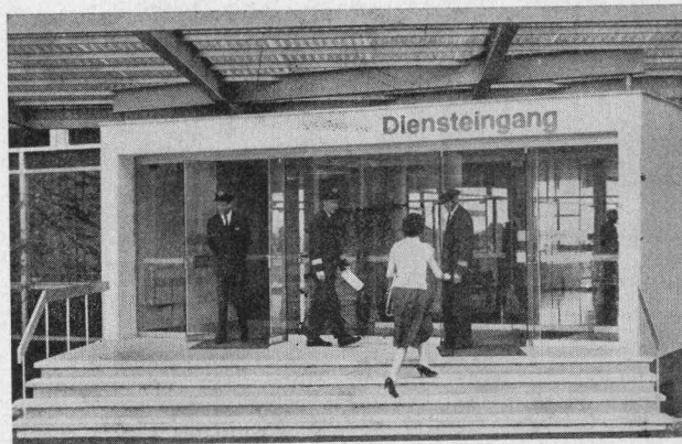
TORMAX im Flughafen Zürich-Kloten: acht Ganzglas-Doppeltüren, angetrieben durch TORMAX, Steuerung durch Kontaktteppiche.
