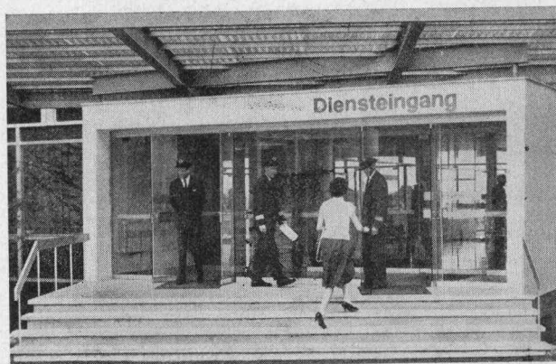
TORMAX im Flughafen Zürich-Kloten: acht Ganzglas-Doppeltüren, angetrieben durch TORMAX, Steuerung durch Kontaktteppiche.
