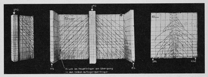
Bild 21. Träger IWT 2 nach dem Bruch bei 120,0 t. Bruchursache: Versagen der schiefen Druckstreben am Uebergang des Hauptträgers in den linken Auflagerquerträger
