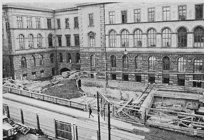
Ausbau des ETH-Hauptgebäudes. Unterfangungsarbeiten an der Nordfassade (Seite Tannenstrasse)
