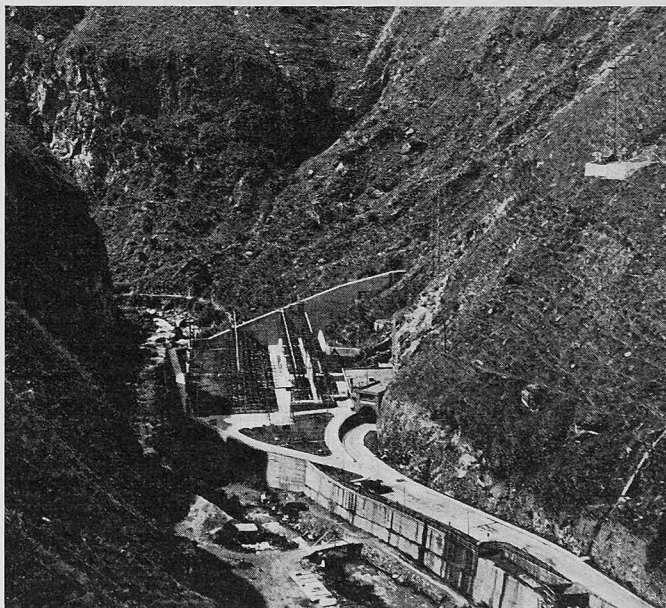
Schaltanlage und Eingang zur Kavennenzentrale des Hochdruck-Kraftwerkes Huinco der Empresas Eléctricas Asociadas, Lima/Peru. Projektierung und Bauleitung Motor-Columbus
