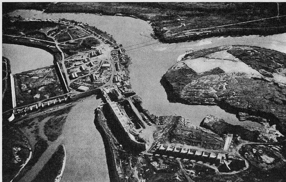
Kraftwerk Cachoeira Dourada in Brasilien. In Betrieb sind zwei Kaplan-turbinen mit einer Leistung von je 24 500 PS. Im Bau sind drei Gruppen von je 68 000 PS und drei Gruppen von je 102 000 PS
