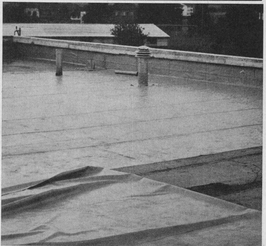
IRONFLEX-Flachdachbelag aus Trevira-verstärktem PVC ohne zusätzliche Schutzschicht, hochfrequenz-verschweisst.
