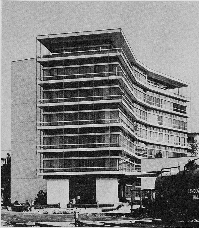
Neues Personalrestaurant auf dem Areal der Firma Sandoz AG, Basel, Hüningerstrasse. Der gegen den Betrachter gerichtete Flügelbau ist nach Norden orientiert
