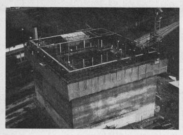
Rohwarensilo der V. L. G.. Herzogenbuchsee, mit Maschinenhaus. Grundriss 20,59 × 22,84 m mit 64 Zellen und Lift. Zwischen Maschinenhaus und Zellentrakt wurde eine ausgebildete Trennfuge mitgezogen. Wandstärke: 12—20 cm. Ziehhöhen: Zellen 22 m, Aufbau über Zellen 8,07m, Maschinenhaus 36,00 m. Betonsichtfläche: 19 000 m². Erstellung vom 15. Juli bis 15. Dezember 1966
