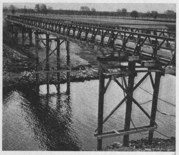
Dienstbrücke La Sauge, im Auftrag der Unternehmung AG Conrad Zschokke, Zürich, während dem Bau der neuen Brücke über die Ziehl. Belastung 16 t. Spannweiten:  $3 \times 21,35 \,\mathrm{m}$  und  $1 \times 12,20 \,\mathrm{m}$ , Fahrbahn  $3,20 \,\mathrm{m}$ , Auflagerung auf Pfahljochen. Zwei Hauptträger aus Bailey-Elementen und Holzbelag, Gesamtgewicht  $35 \,\mathrm{t}$ . Montage im Freivorschub ab Montagebühne, Zeitaufwand:  $3^{1/2}$  h/t.
