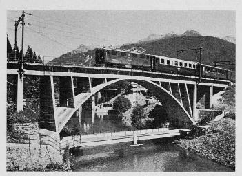
Bild 22. Landquartbrücke der Rhätischen Bahn bei Klosters, erbaut 1930 nach dem Projekt von Ing. R. Maillart, Genf. 1943/44 Einbau des Druckriegels mit Messvorrichtung zur Messung des Riegeldruckes (vgl. Bild 23)
