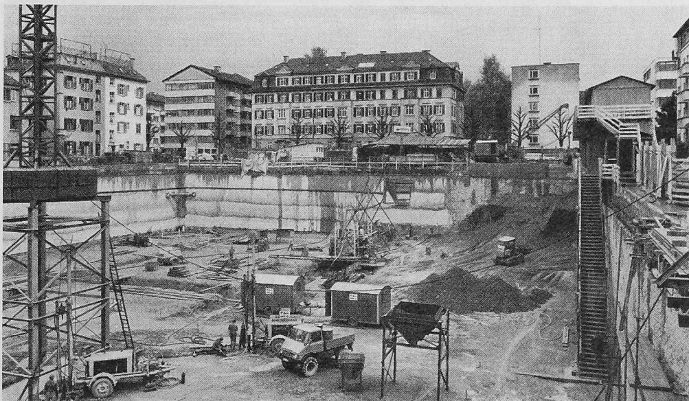
Bild 19a (oben): Sicherung einer Schlitzwand und einer Bodenplatte gegen Auftrieb mit Duplex-Ankern
