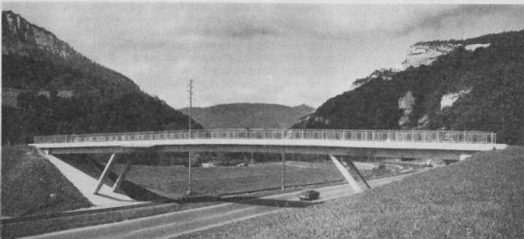
Bild 1. Ansicht der Überführung Oensingen
