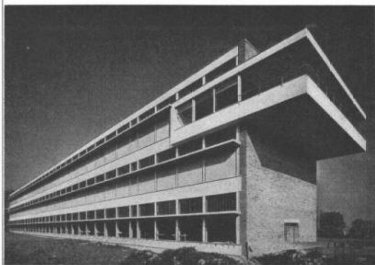
Neubau des Schützenhauses Zürich-Albisgölli
