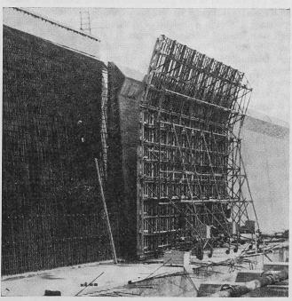
Bauunternehmer ein neues Schalelement zur Verfügung, das einerseits durch Verwendung von Eisenprofilen anstelle von Kanthölzern sowie grossen fugenlosen Schalflächen neue Wege geht, anderseits dem Unternehmer ermöglicht, die bis heute in seinem Betrieb bewährten Schaltafeln weiterhin zu verwenden. Das System wird durch die Firma Construvit AG in Lyss vertrieben.
