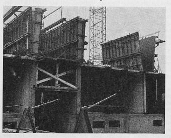
Bild 2. «Konstal»-Grossflächenschalung
