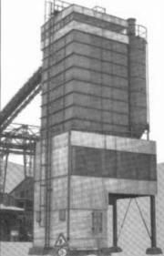
Leistung ca. 40—50 m³/h 2 Sorten Zement à 50 t Inhalt 4 Zuschlagstoffe à 30 m³ Inhalt 1 Zwangsmischer, 1500 t Inhalt Lochkarten-Steuerung Beschickung der Anlage durch Schrägförderband Leistung ca. 40–50 m³/h
