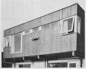
Neuzeitliche Holzfassade (England). Die Fassaden des Hauses sind senkrecht verschalt ohne Vordach. Die Fenster wurden nahezu fassadenbündig eingesetzt und sind gegenüber den Witterungseinflüssen stark exponiert
