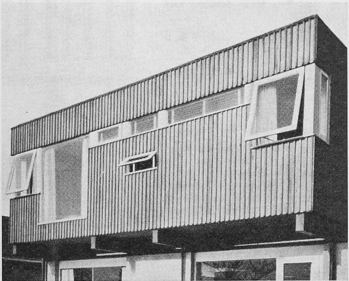
Bild 4. Neuzeitliche Holzfassade (England). Die Fassaden des Hauses sind senkrecht verschalt ohne Vordach. Die Fenster wurden nahezu fassadenbündig eingesetzt und sind gegenüber den Witterungseinflüssen stark exponiert
