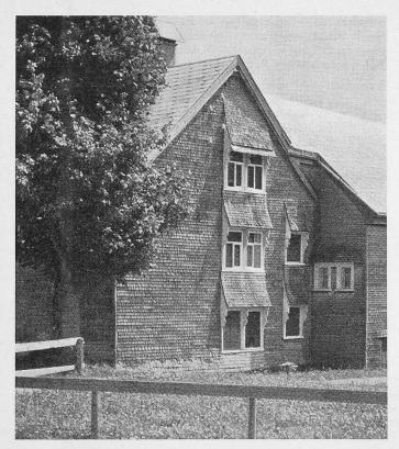
Bild 3. Verschindelte Fassade eines ostschweizerischen Bauernhauses ohne ausgeprägten Dachvorsprung. Eine geschiftete Fensterverdachung (mit Abwurf) und seitlich angebrachte Brettvorstösse schützen die Fensterkonstruktion. Man erkennt die Sorge des Handwerkers, das Fenster gegen den Regenanfall vollständig zu schützen
