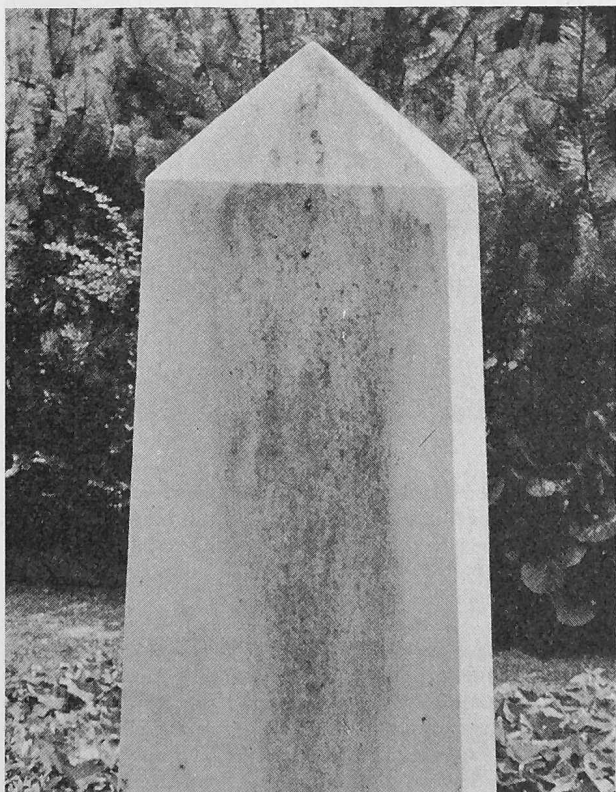
Bild 12. Starke Verfärbungen an einem Grabstein aus Carrara-Marmor
