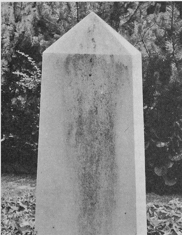
Bild 12. Starke Verfärbungen an einem Grabstein aus Carrara-Marmor
