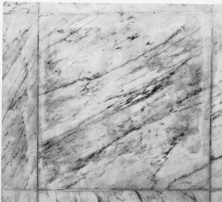
Bild 9. Verfärbte Bodenplatten aus pyritreichem Carrara-Marmor. Die Randpartien der Platten sind durch die konservierende Wirkung alkalischer Infiltrationslösungen aus dem Fugenmörtel unverfärbt geblieben
