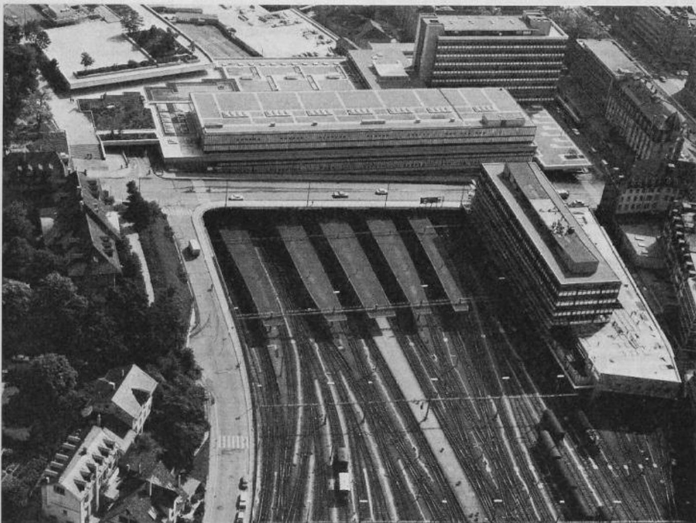
Bild 65. Die PTT-Bauten und die neue Schenzenbrücke, Flugbild aus Westen
