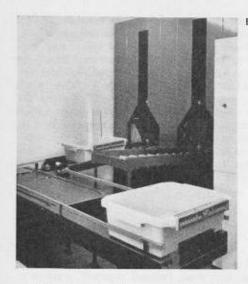
B.ld 42 (rechts). Fassadenreinigungsanlage, auf dem Dach des Hochhauses montiert
