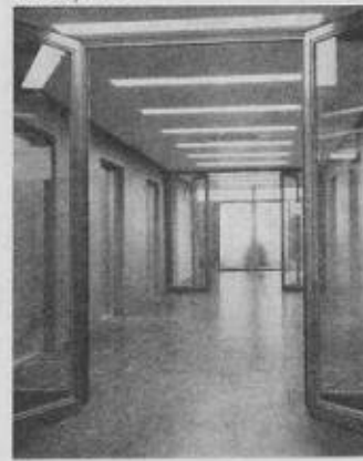
Bild 31. Einbauleuchten an den Liftvorplätzen
