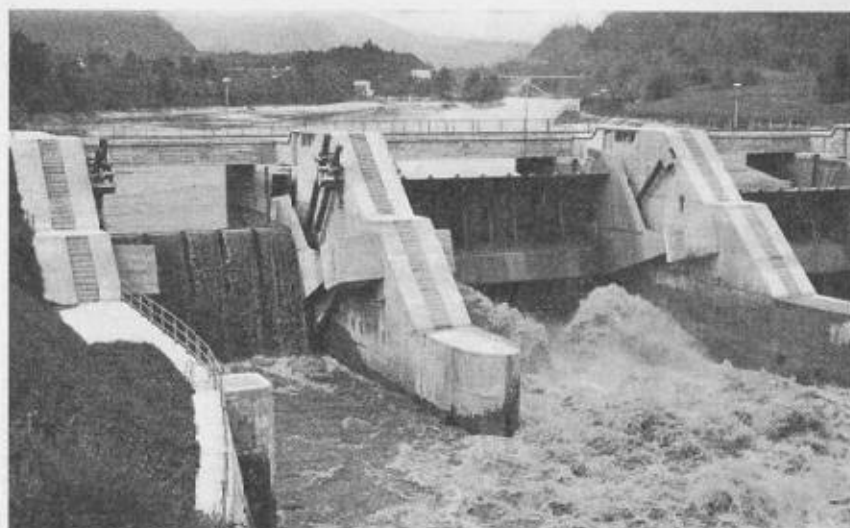
Bild 11. Spülöffnung (links) und Regulieröffnung (rechts)
