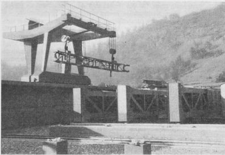
Bild 8. Dammbalkendepot mit Versetzkran
