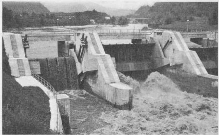
Bild 11. Spülöffnung (links) und Regulieröffnung (rechts)
