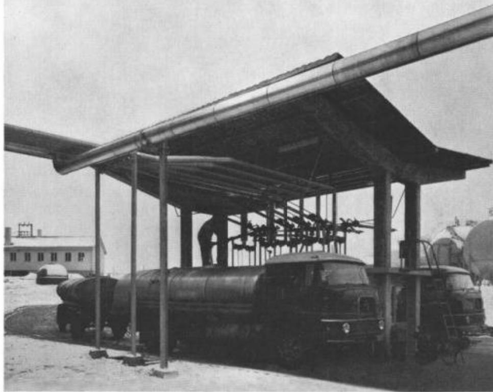
Moderne Camion-Abfüllstation für Benzin und Heizöl in einem Gross-tanklager.
