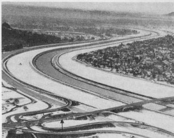
Anschlussbauwerke Au/SG der N 13, Ende des vierspurigen Ausbaus, mit Zollabfertigungsgebäude (siehe Pfeilbezeichnung). Entnommen der Schrift «Nationalstrassen N 1 + N 13», herausgegeben vom Baudepartement des Kantons St. Gallen, 1964, Seite 15
