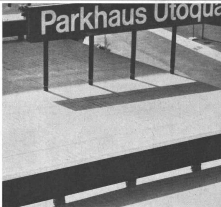
IRONFLEX-Flachdachbelag aus Trevira-verstärktem PVC ohne zusätzliche Schutzschicht, hochfrequenz-verschweisst.
