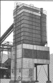
Leistung ca. 40–50 m³/h 2 Sorten Zement à 50 t Inhalt 4 Zuschlagstoffe à 30 m³ Inhalt 1 Zwangsmischer, 1500 l Inhalt Lochkarten-Steuerung Beschickung der Anlage durch Schrägförderband Leistung ca. 40–50 m³/h
