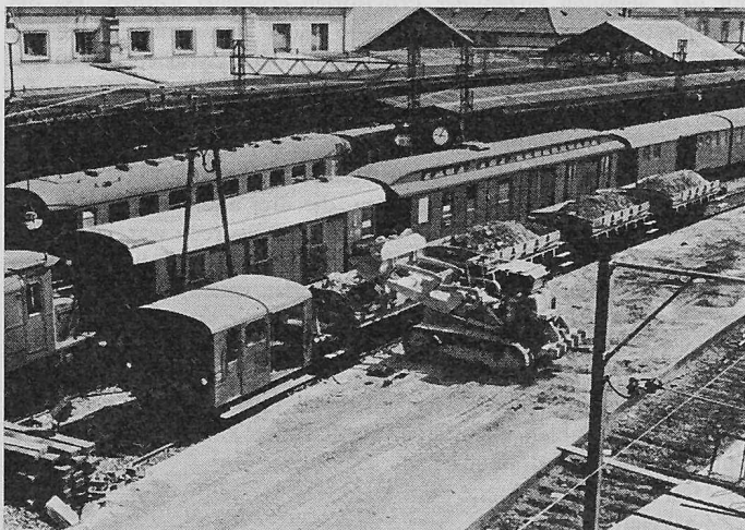
Bild 23. Verlad von Aushubmaterial der Inselbaustelle auf Bahnwagen
