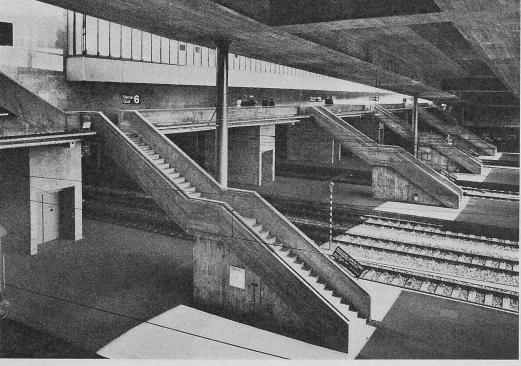
Bild 45. Untersicht der Schanzenbrücke. Unter und neben der Brücke die Passerelle West mit Treppenabgängen auf jeden Perron
