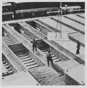
werden, ist ein genaues Einpassen nicht nötig, und gewisse unregelmässige Überstände sind bedeutungslos. Damit konnte auf die Anfertigung spezieller, trapezförmiger oder rhombischer Platten verzichtet werden. Die Fabrikation einer sehr grossen Zahl gleicher Platten war damit gesichert.
